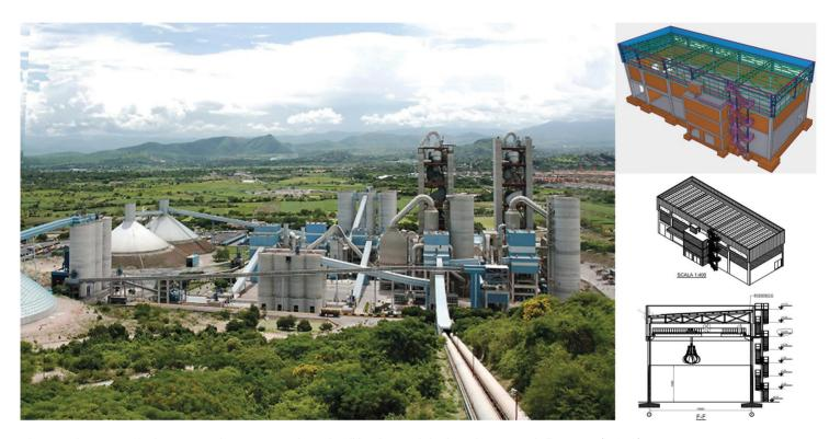
Proyecto de construcción de nave para almacenamiento de combustibles alternos de la planta de cemento de Tepetzingo (México) con dimensiones en planta de 52.7x20m y altura aproximada de 19.6m. La estructura se conforma con pórticos de hormigón hasta el nivel de apoyo del puente grúa y cubierta metálica con distancias máximas entre pórticos de 11.75m
